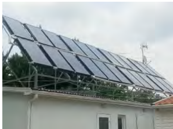
Солнечные коллекторы на крыше здания
