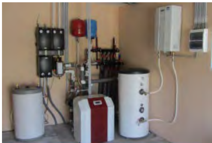
Теплонасосная установка
