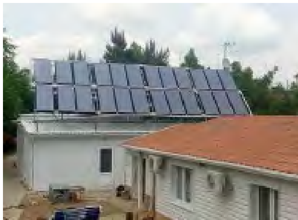
Солнечные коллекторы на крыше здания
