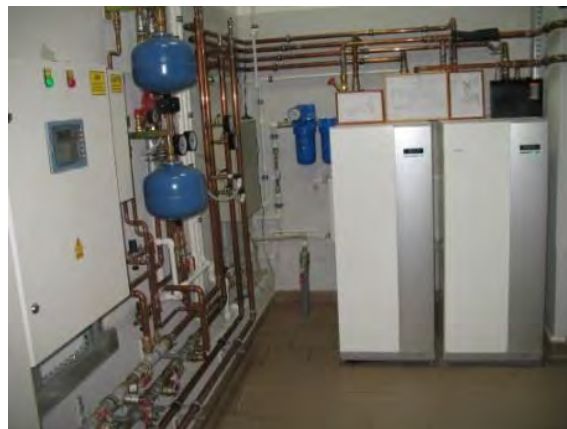
Теплонасосная установка
