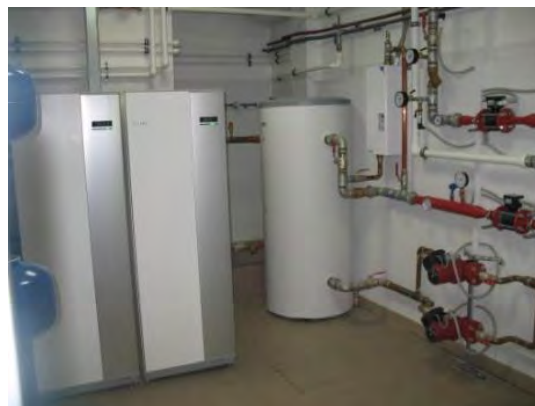
Теплонасосная установка
