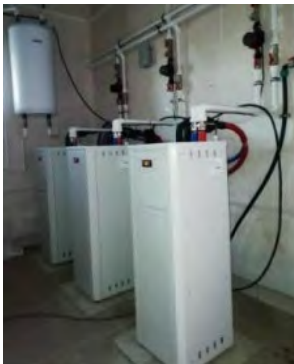
Теплонасосная установка
