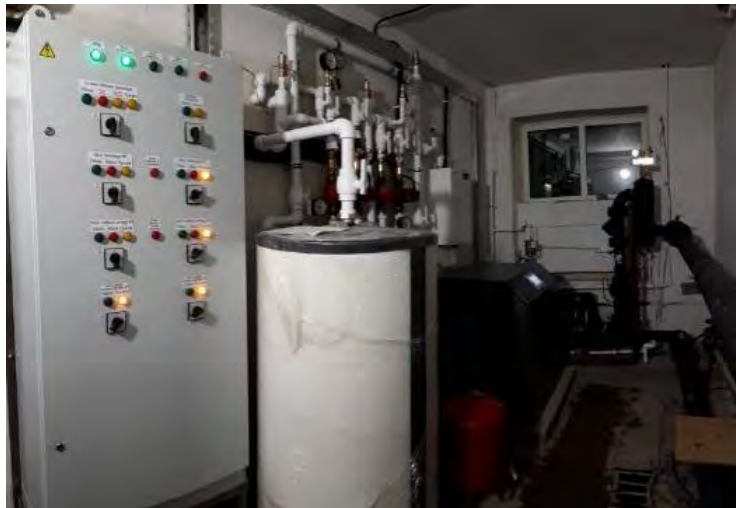
Теплонасосная установка
