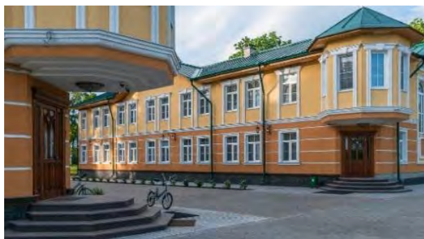
Большой гостевой дом
