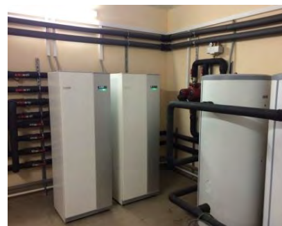
Теплонасосные установки
