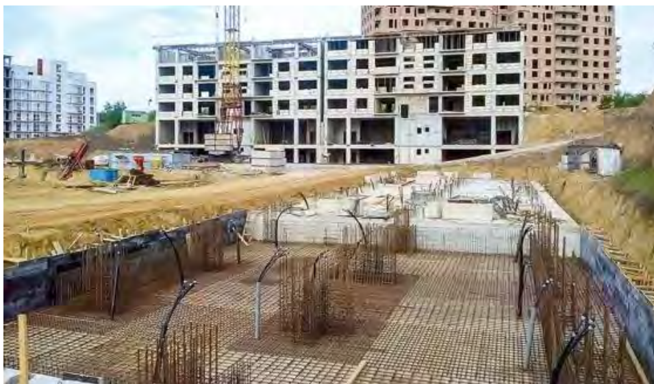
Строительство комплекса EcoMoldova
