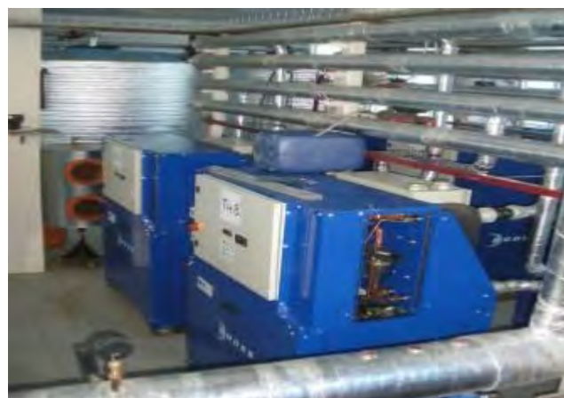
Теплонасосные установки
