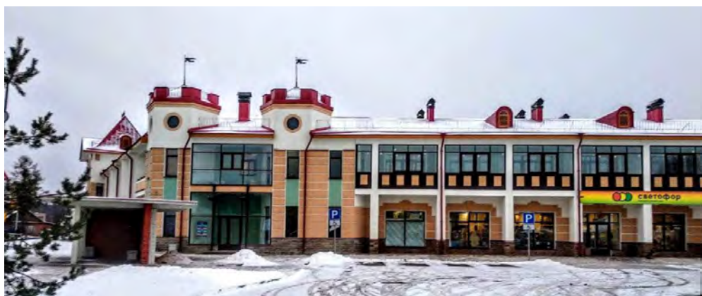
Общий вид здания
