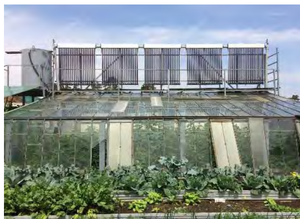
Теплица с обогревом от солнечных коллекторов
