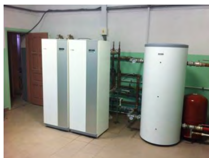
Теплонасосная установка
