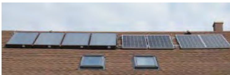
Солнечные коллекторы и фотоэлектрические панели на крыше дома
