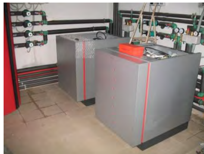
Теплонасосные установки
